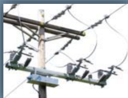
Выключатель нагрузки – разъединитель Время отключения >35 мс
