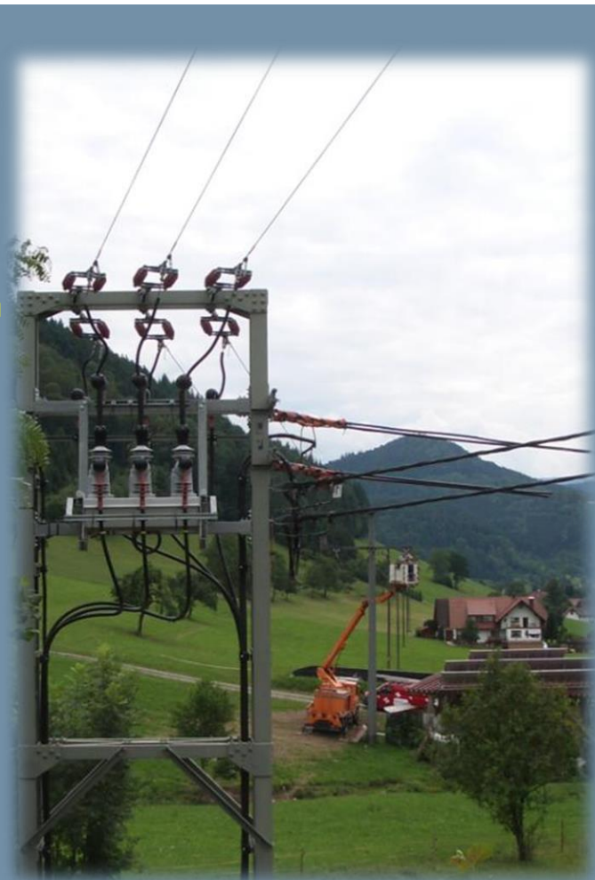
Фьюсейвер (FS) 10 кВ / 4 кА / 200 А Время отключения = 2 мс
